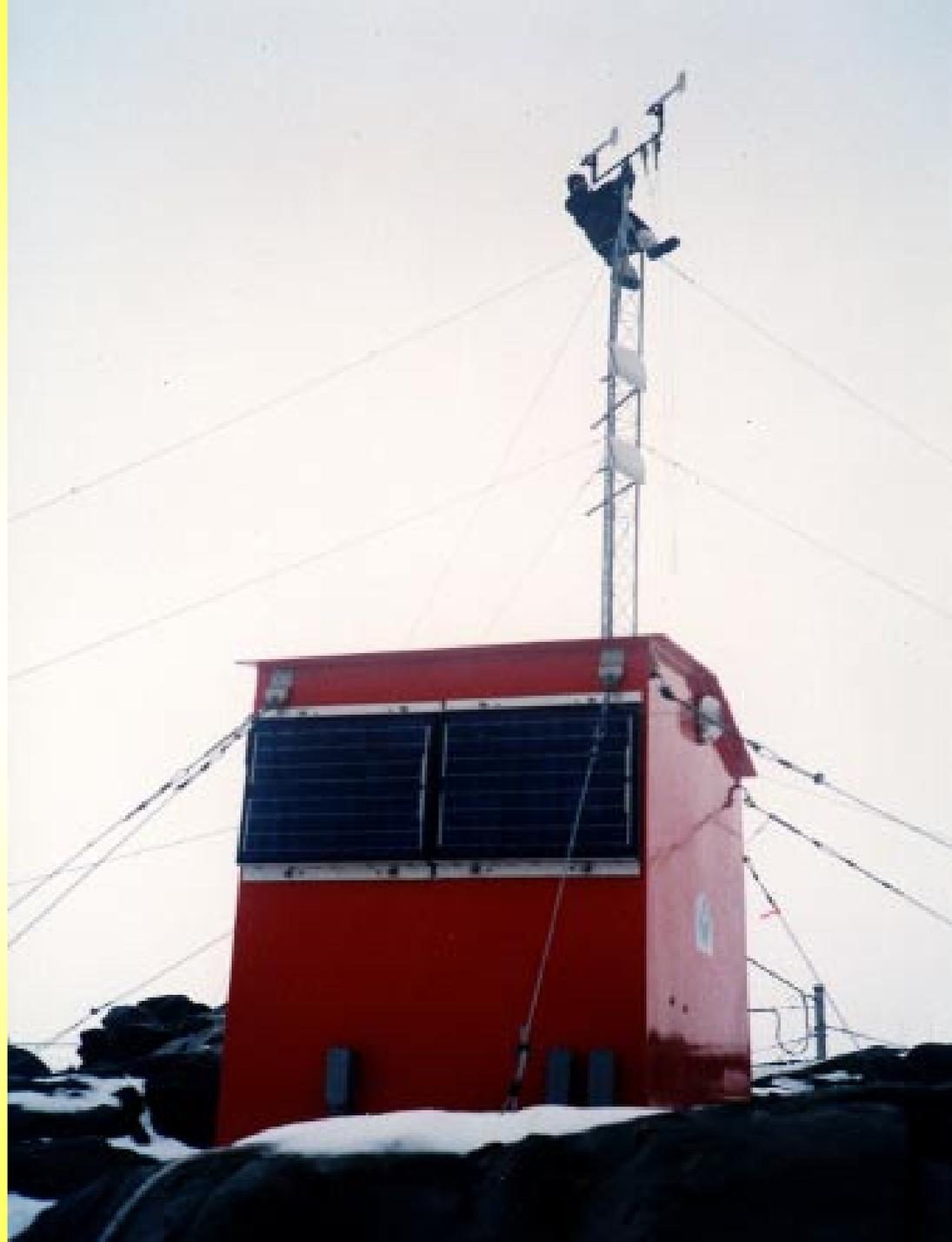
Como consecuencia de las exigencias del terreno se debió modificar el diseño original de este tipo de estaciones, instalando el sensor acústico a 45°.
